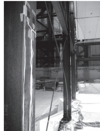
写真2 K-NET 仙台波 80%加振後の壁ブレースの座屈変形
