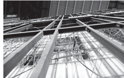
写真3 全加振後の屋根ブレースの座屈変形
